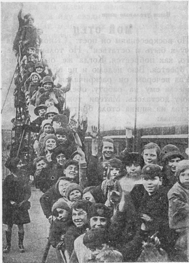
Митинг шведских пионеров на... пожарной лестнице
